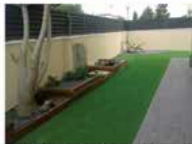
INSTAL·LACIÓ GESPA ARTIFICIAL · JARDÍ PARTICULAR
